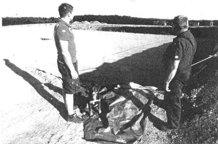
Banger Blick in die Zukunft: Hier entsteht der hochmoderne Kuhstall, ein Millionenprojekt.
