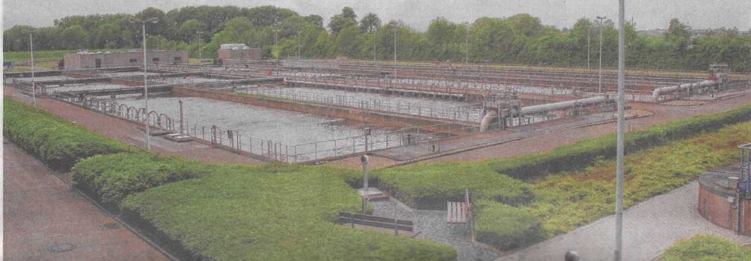
In der Kläranlage Salmorth Kleve wird aus Grundwasser Trinkwasser.
