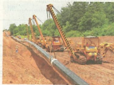
Die „Zeelink“-Leitung soll in der Erde verlegt werden
