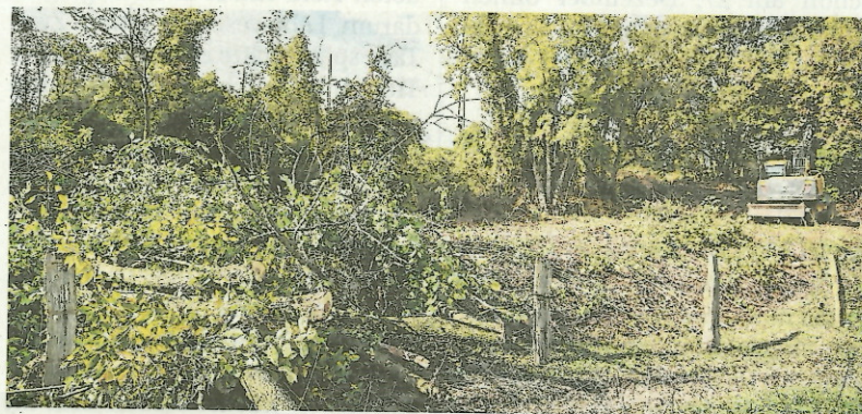
An der Bahnlinie in der Nähe der Schillwiese finden Rodungsarbeiten für die geplante B 58-Südumgehung statt.
